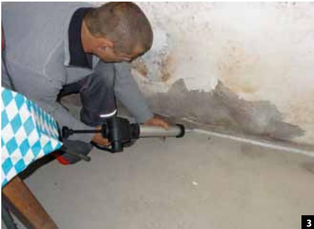
**Abb. 3:** Randfugen in einem Radon-belasteten Keller lassen sich zum Beispiel mit Dichtungsmassen abdichten. Das dichte Schließen der Fugen ist wichtiger als die Wahl und Qualität des Materials.
