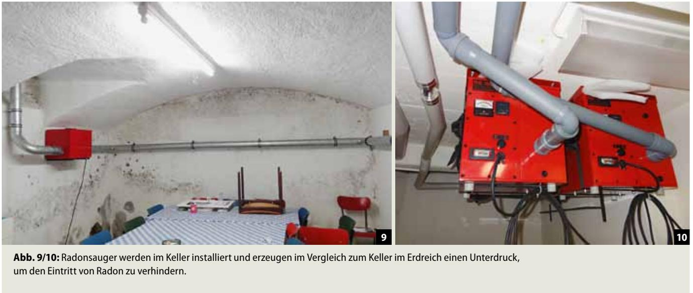
Abb. 9/10: Radonsauger werden im Keller installiert und erzeugen im Vergleich zum Keller im Erdreich einen Unterdruck, um den Eintritt von Radon zu verhindern.
